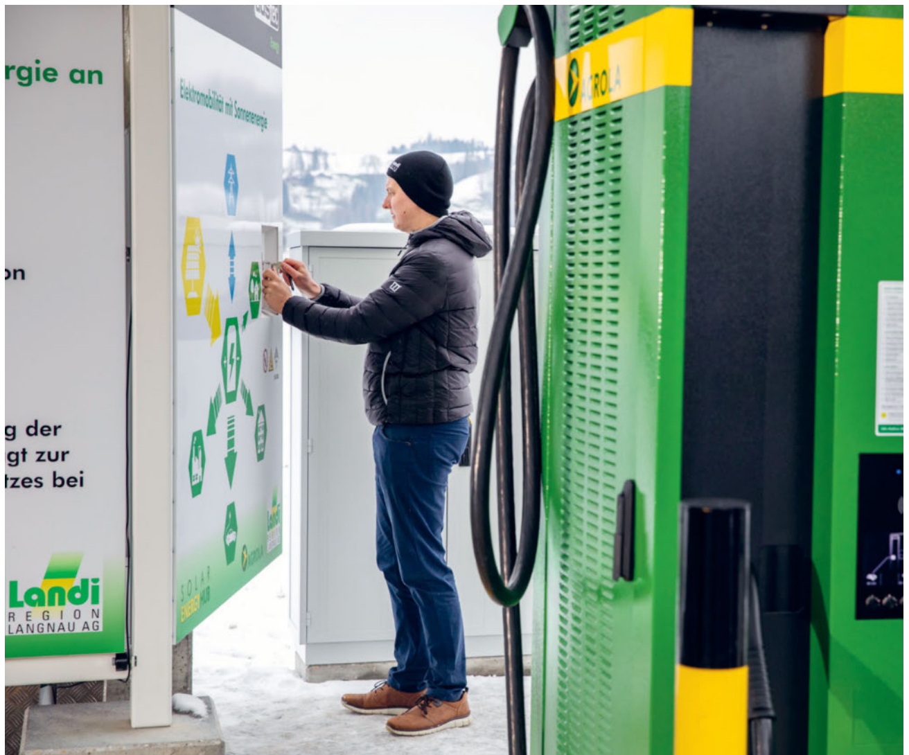
Elegante Lösung: Da die Speicherbatterie direkt neben der Schnellladestation steht, braucht es nur ein kurzes Stück der teuren Hochstromleitung.
