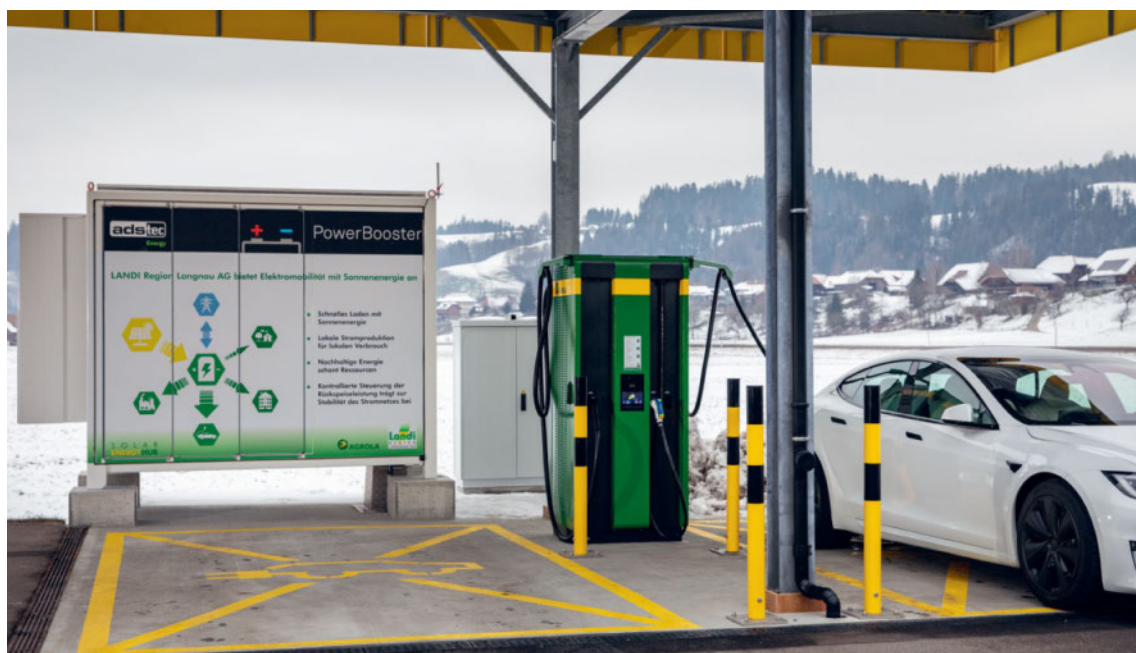
An der Schnellladestation in Zollbrück (BE) kann ein Elektroauto in lediglich 15 Minuten Energie für 250 Kilometer Reichweite laden.
