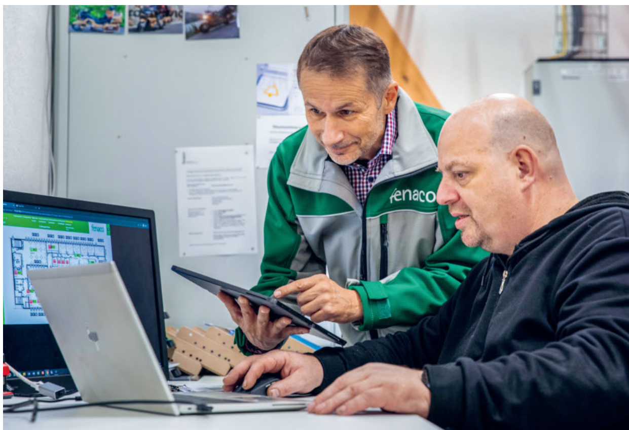
Roland von Däniken et Urs Schneider surveillent la consommation d'électricité via le poste de commande central.
